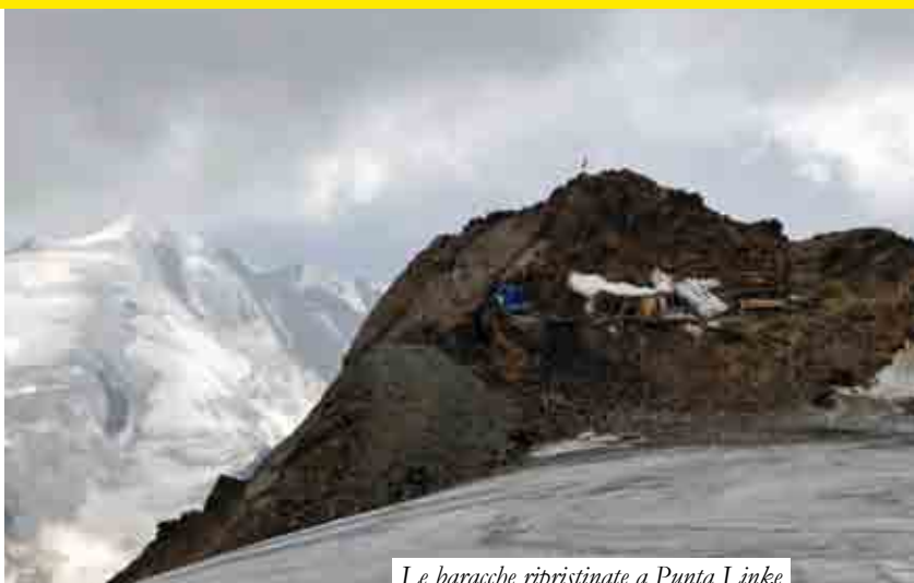
Le baracche ripristinate a Punta Linke
